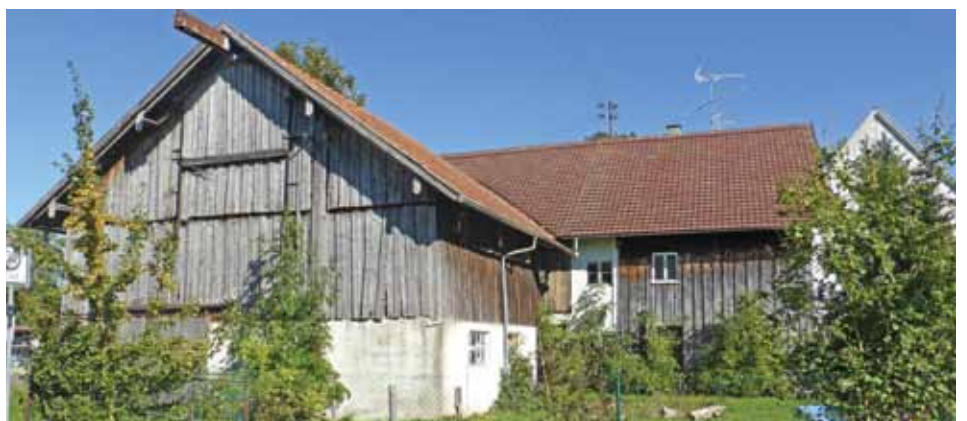
Von der Südwestseite her, wo die Vorrichtungen für den Heuaufzug gut zu sehen sind. (Foto: Ulrich Müller, 2023)
