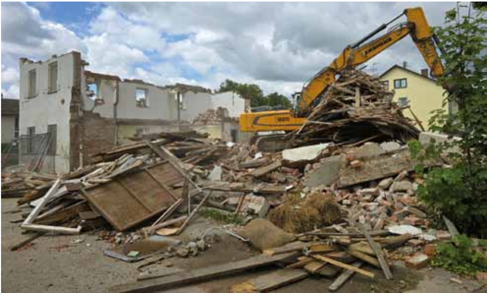
Abrissarbeiten Aurbacherhaus (Bild: Gemeinde Wiedergeltingen)
