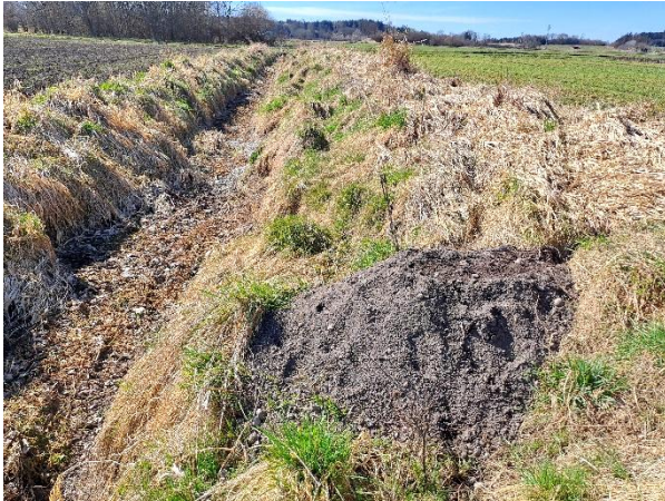
Abb. 13 Deutlich erkennbarer Erdbau am temporär wasserführenden Graben im Südosten des PG
