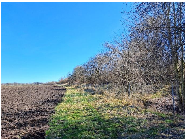
Abb. 9 Lärmschutzwall entlang A 96 (Blick nach Osten)
