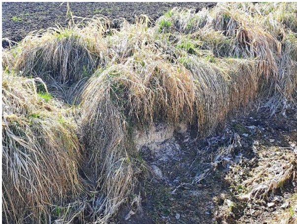
Abb. 4 Deutlich erkennbare Sinterkalkschicht im Bereich des temporär wasserführenden Grabens
