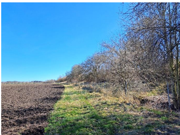
Abb. 9 Lärmschutzwall entlang A 96 (Blick nach Osten)
