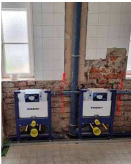
Auch innen wird kräftig gearbeitet; hier: Umbau der WC-Anlagen im „alten Pfarrhof“
