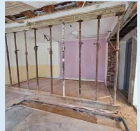
Abschluss der Abbrucharbeiten (Foto: Norbert Führer)
