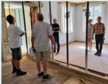
Begutachtung der Abbrucharbeiten (Bild: Norbert Führer)
